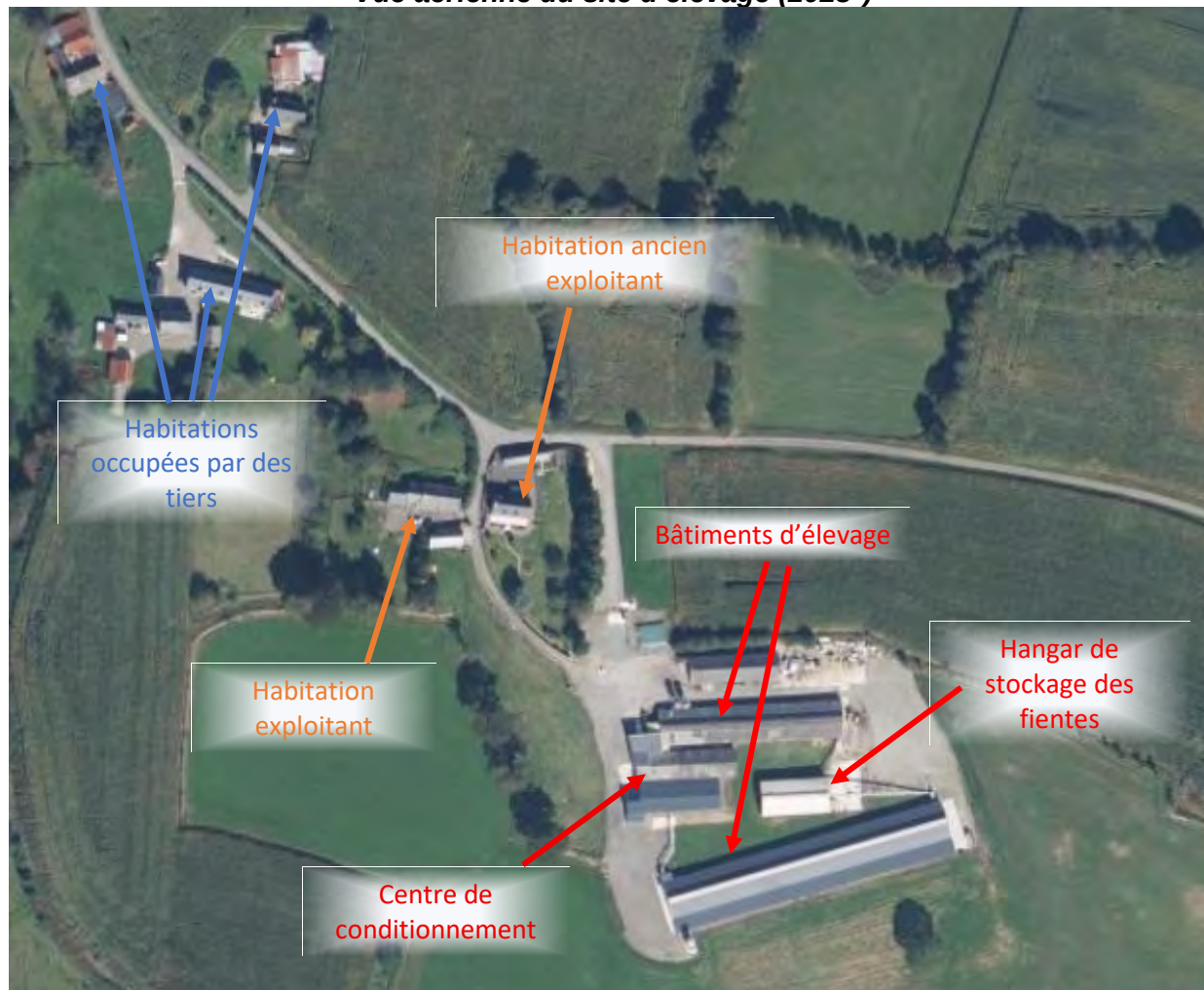
Vue aérienne du site d'élevage (2023 9 )
